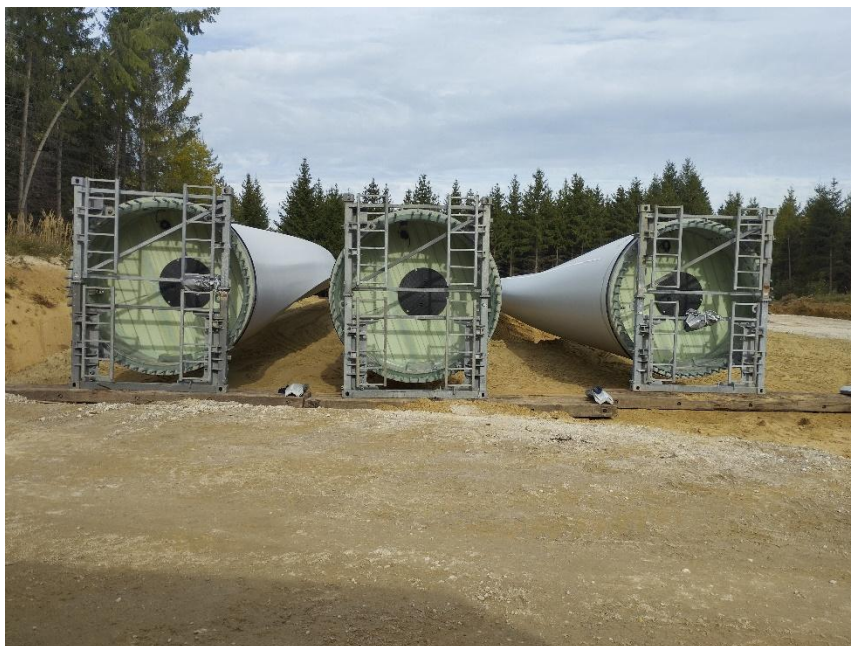
Slika 24 – Gradilište vjetroelektrane u Pfaffenhofen an der Ilm
