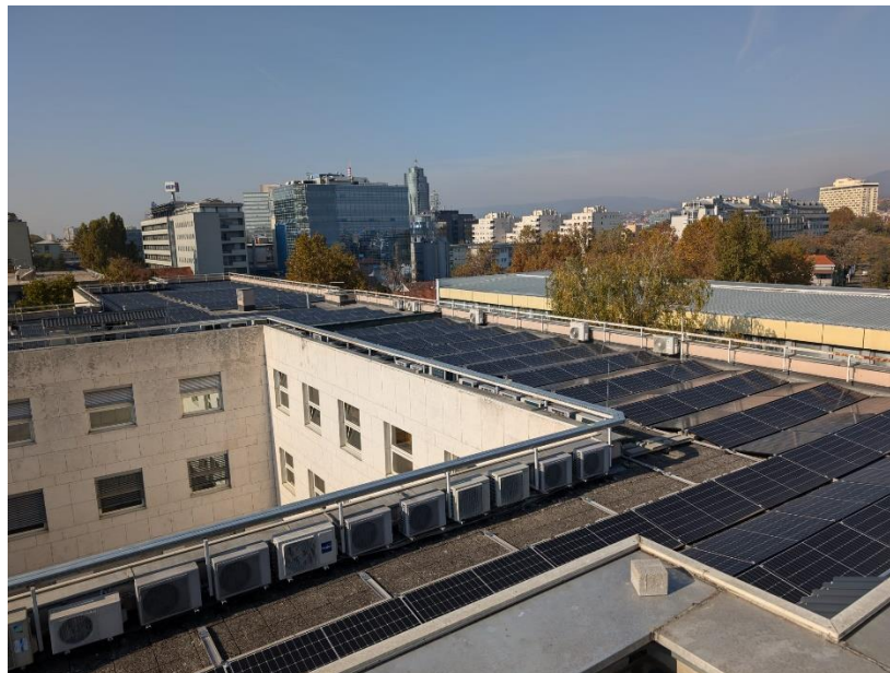
Slika 13 – Sunčana elektrana na krovu Fakulteta elektrotehnike i računarstva
