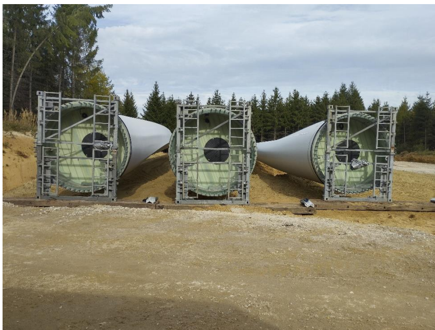
Slika 19 – Gradilište vjetroelektrane u Pfaffenhofen an der Ilm
