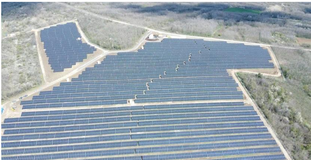
Slika 16 – Sunčana elektrana DeLasol
